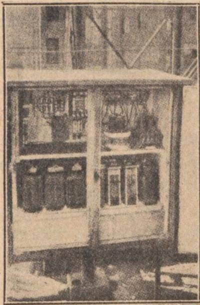
une tension alternative de 20 volts ; il débite sur un redresseur B', qui maintient une différence de potentiel de 8 volts,6 aux bornes de 4 éléments en série constituant la batterie de ligne s'.
