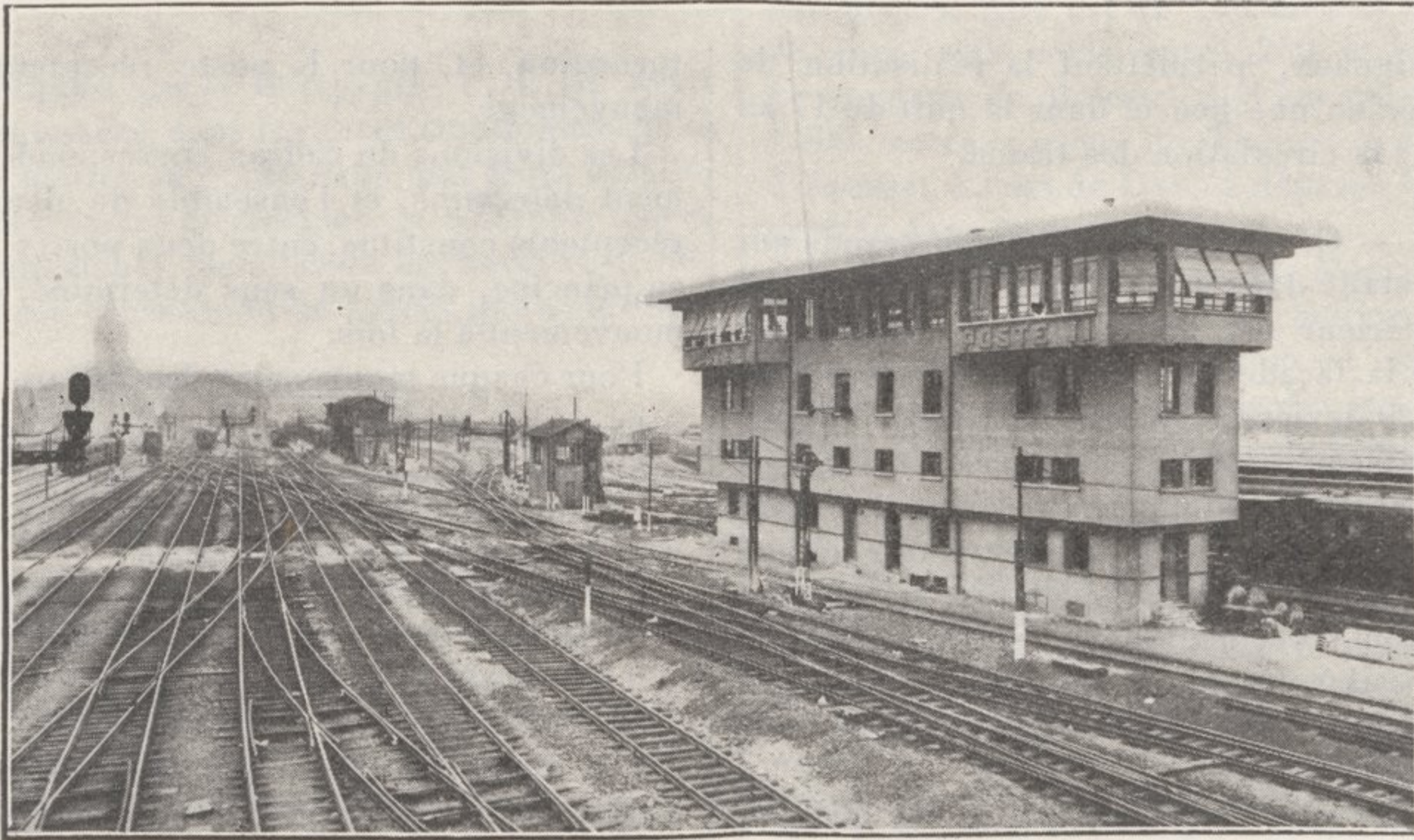
FIG. 1. — Vue générale du poste de signalisation électrodynamique de la gare de Paris P.-L.-M.
