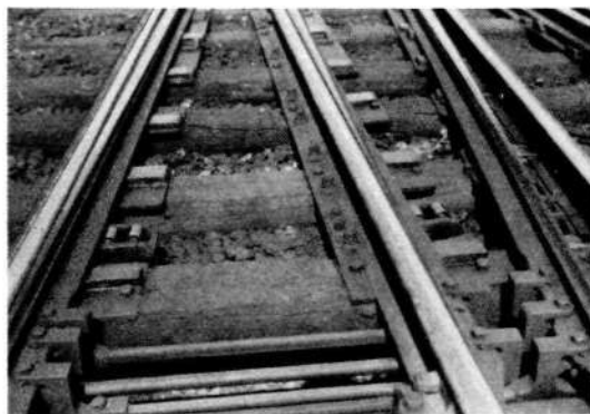
Fig. 20. Point rollers.
