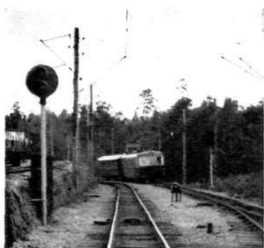
Fig. 5 Utfart norrut från Stockholm O f. v. infartssignalen H till första blocksträckan, i mitten mellan spåren baksidan av dvärgsignalen, längre t. h. infartssignalen A \frac{1}{2}
