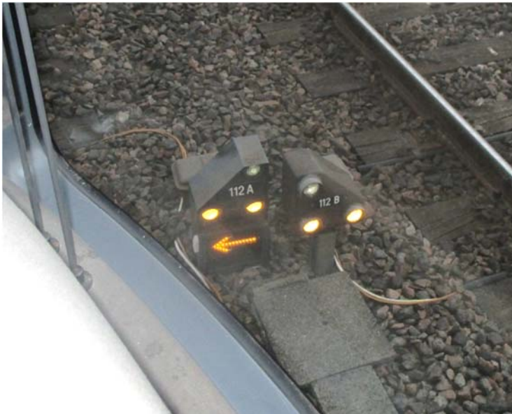
Abbildung 2: Zwergsignale zwischen den Gleisen 1 und 2 von Winterthur. Blick aus dem Seitenfenster der wegzustellenden Triebzuginheit.
