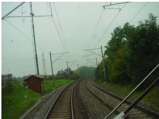
Sicht von Bahnkm 71.000 Richtung Blocksignal S 272 bei Bahnkm 70.673.
