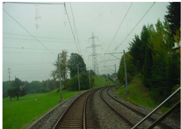
Sicht von ca. Bahnkm 70.800 Richtung Blocksignal S 272 bei Bahnkm 70.673.
