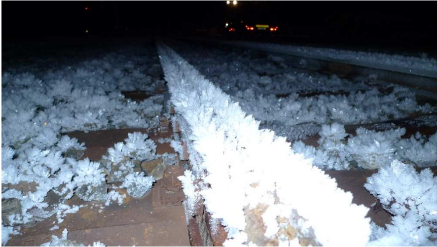
Bild 2 Eiskristallbildungen auf der Schiene hier Gleis 1
