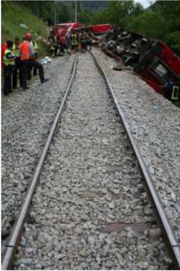
46番支柱付近のレールの歪み
