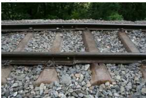
溶接された SBB1 型レール(左)と VST 型レール(右)の交差部分
