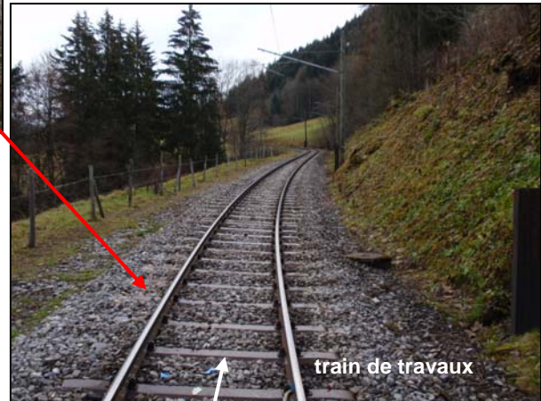
Vue du train de travaux en amont
