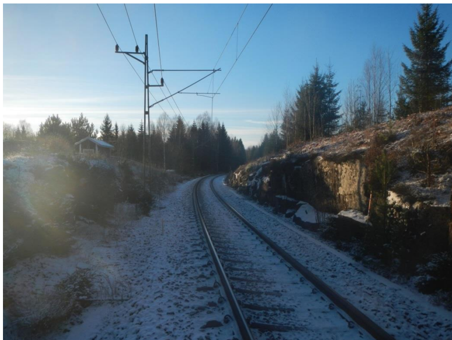
Figur 8. Fotot visar den kurva som hjälpfordonet färdades genom, i riktning från fotografen, strax innan kollisionen. Fotografiet är taget vid ett senare tillfälle (december 2016).
