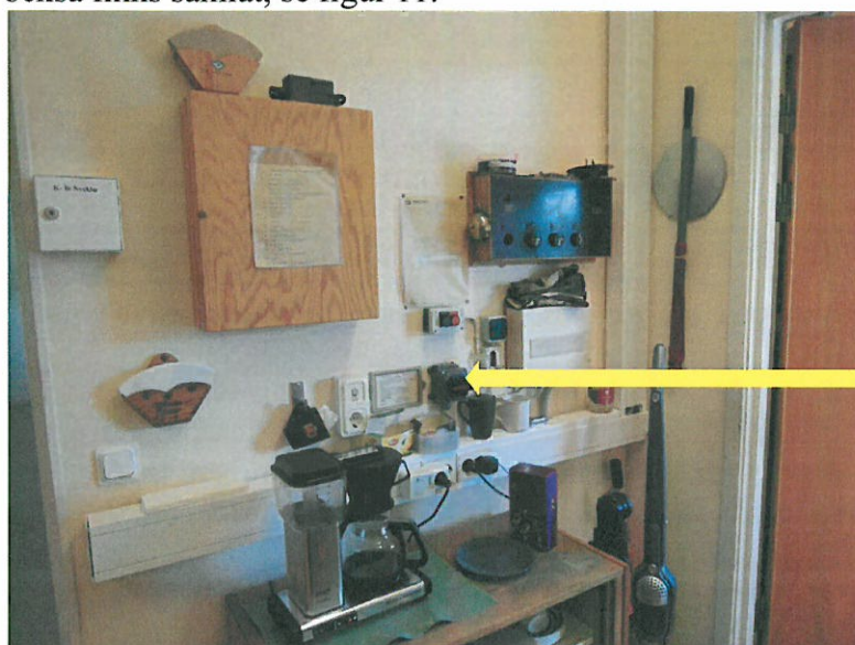
Figur 11. Knapp för fränkoppling av kontaktledning; placering i Smedjebacken.
