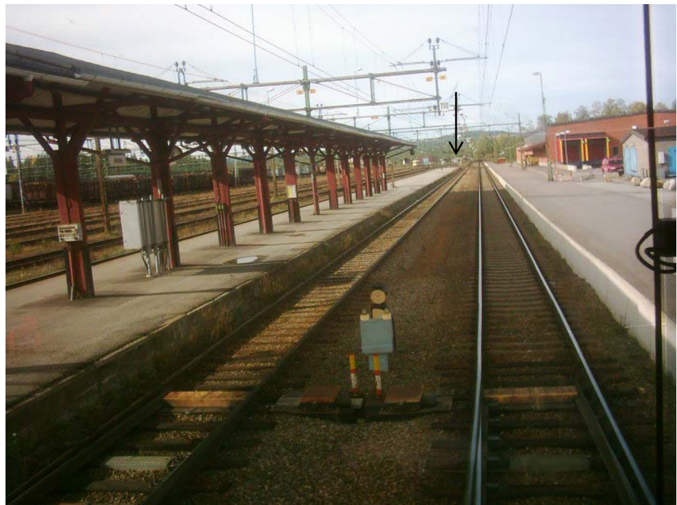
Spår 1 i Ånge. Signal 160 kan knappt skönjas vid pilen.
