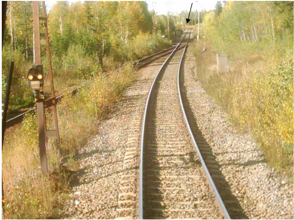
Spåravsnittet från signal 202 med växel 403 och vidare mot utfartsblocksignal L2, som kan skönjas vid pilen. Något innan den punkt där bilden är tagen går det att urskilja om utfartsblocksignalen visar "stopp".
