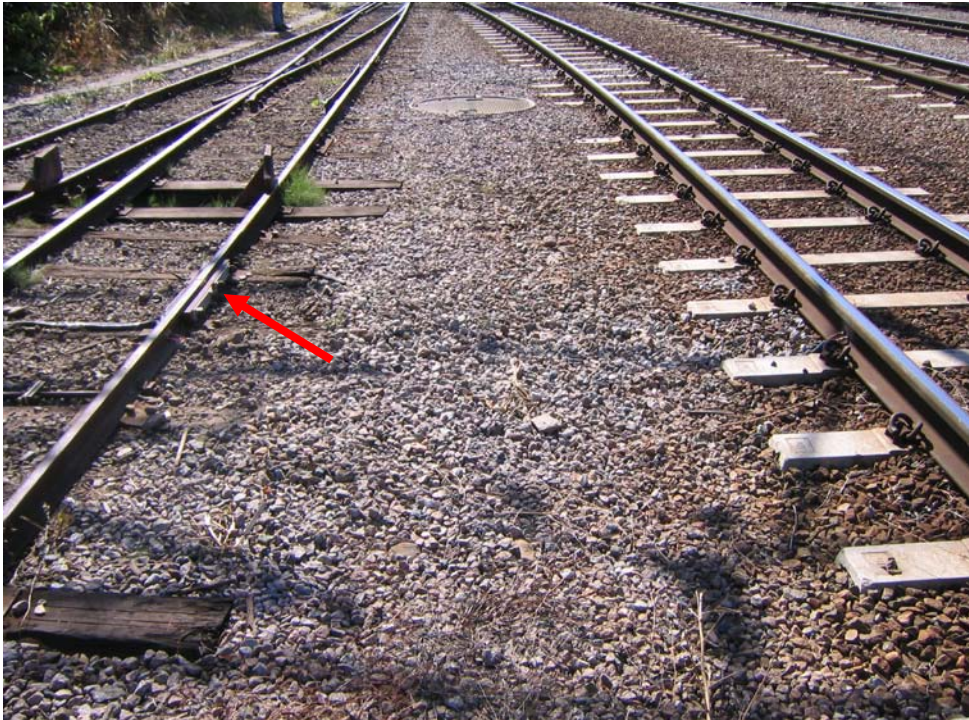
Fig. 2 På bilden syns spårspärr 621 uppe till vänster i bild. Skarven för spårledningen syns strax hitom spårspärren (röd pil). Motorvagnen hade nästan helt passerat spårspärren när den gick upp under vagnen.
