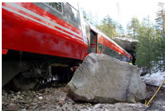
Figur 6: Viser en steinblokk som stammer fra raset. Bildet er tatt mot tunnelåpningen.
