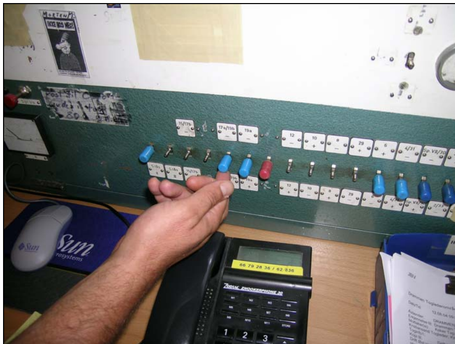
Figur nr. 1: Utsnitt av stillerapparat (og sporvekselstiller) på Asker stasjon
