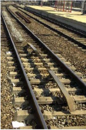
Le crocodile est un appareil situé entre les deux rails de la voie qui aide le conducteur à respecter les indications fournies par un signal ou un panneau.
